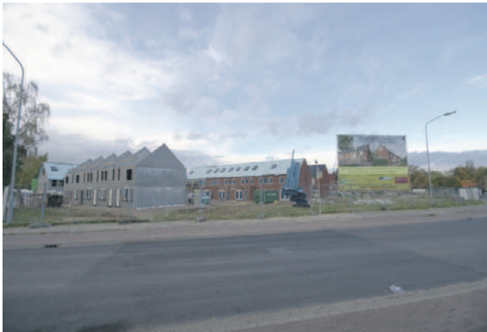
Langs de Churchillweg wordt op dit moment druk gebouwd aan de tweede fase van De Ambacht.
